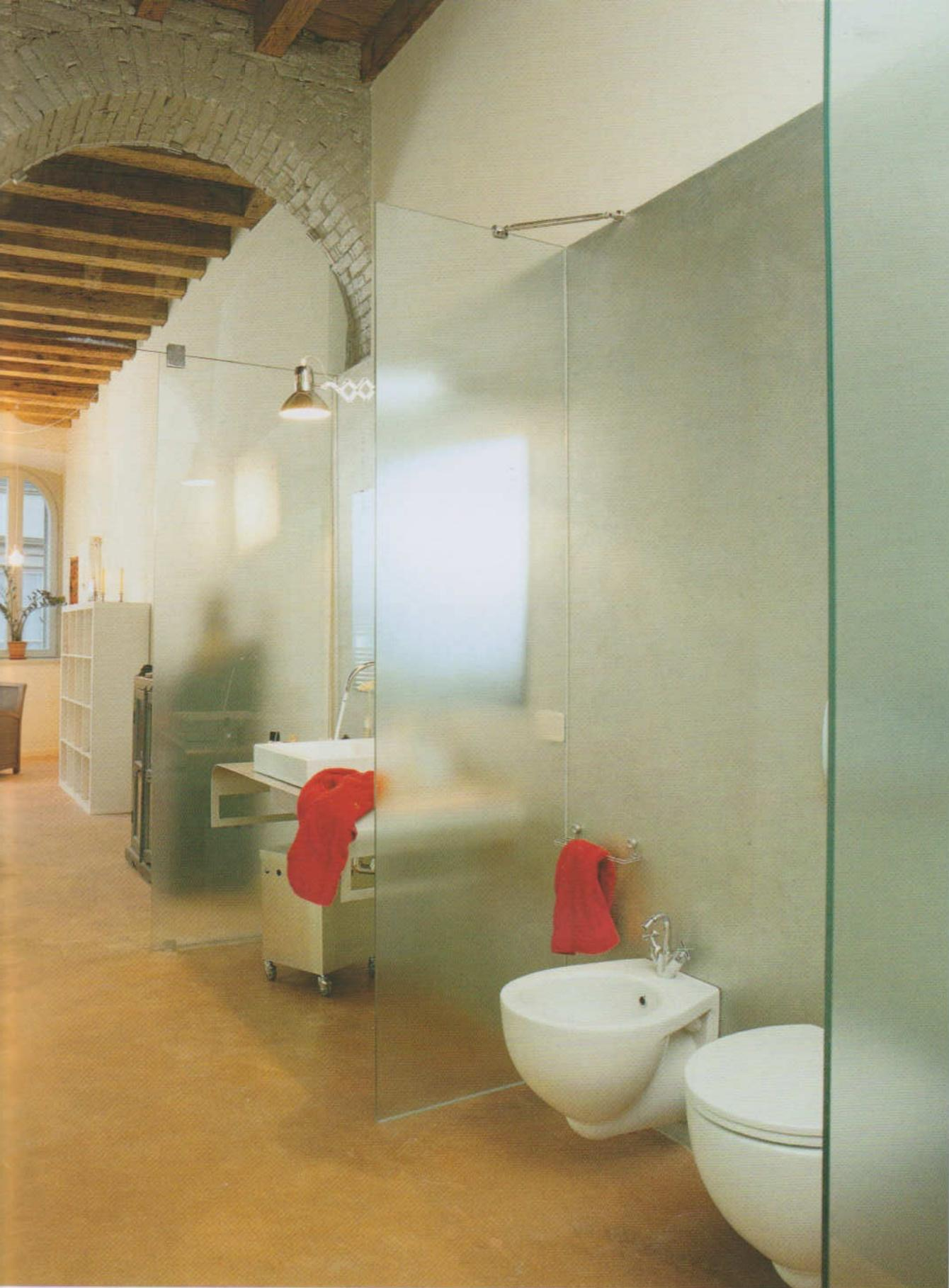
architettoniche, cui è stata posta particolare attenzione: dal soffitto a travi in legno pulite e trattate nuovamente, alla struttura portante ad arco e pilastri in mattoni, sottoposti a pulitura e trattamento consolidante con successiva protezione superficiale in smalto all'acqua effetto metallizzato.
