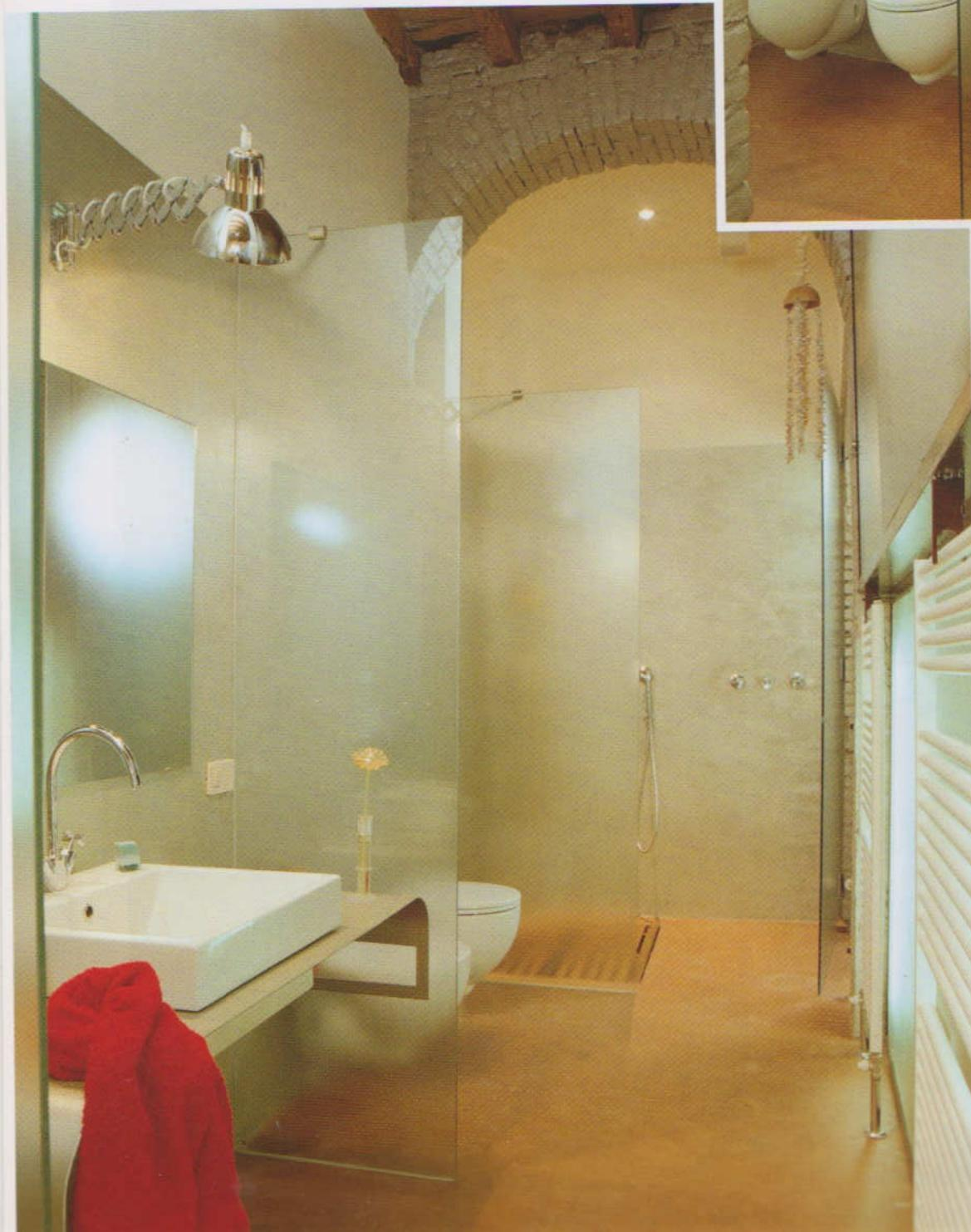
Tra una zona funzionale sono state installate quin pre di cristallo, che scand sequenza delle aree, esa la specifica singolarità. Il pavimento è stato ras una miscela di resine ac polveri di marmo a base zia e protezione super resina poliuretanic, dell tipo di quella che è stata parete quale finitura per nell'area bagno. Diverse lità: un caldo color cott mento e grigio a parete. Il progetto esalta le pre
